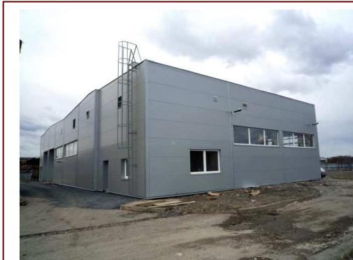
Výstavba haly dílen
