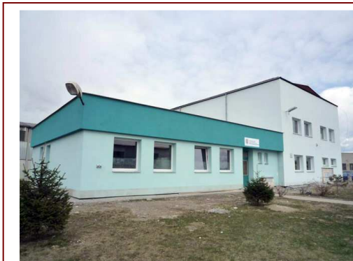
Oprava administrativní budovy v areálu Technických služeb města Olomouce
